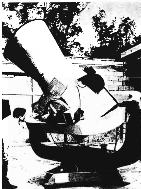
Камера за фотографско одређивање положаја вештачких сателита из којих се израчунавају њихове путање.
