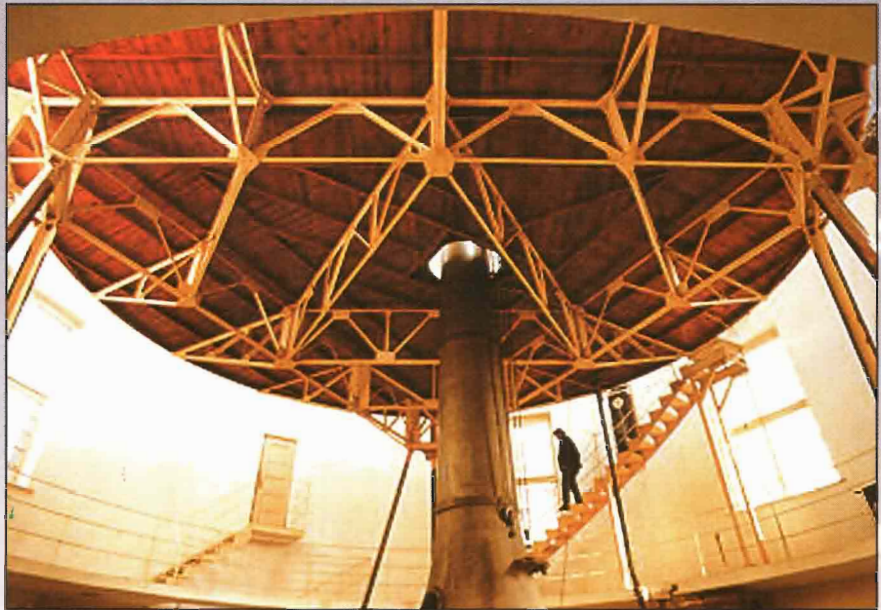
Το ανυψούμενο δάπεδο του μεγάλου διοπτρικού τηλεσκοπίου, παρόμοιο με το ανάλογο δάπεδο του ελληνικού μεγάλου διοπτρικού τηλεσκοπίου στην Πεντέλη, όπως φαίνεται από την είσοδο του θόλου.
