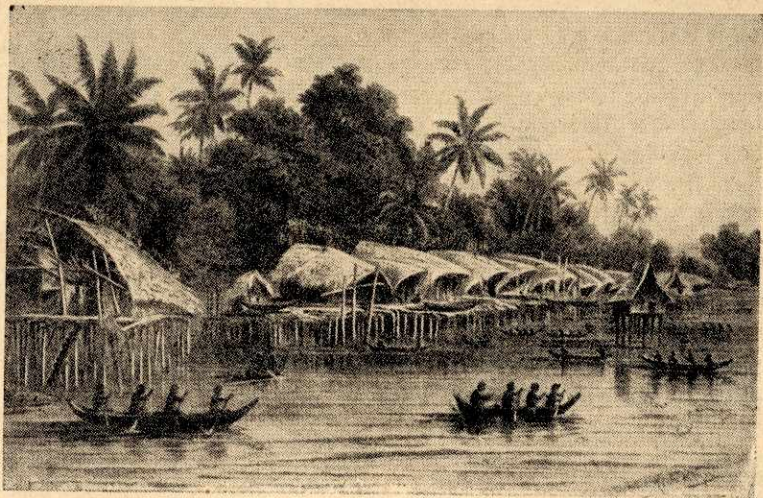
Сл. 89 — Изглед једног црначког насеља на кољу.
